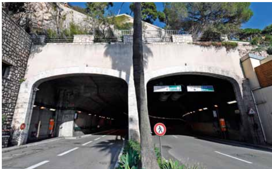
Le Tunnel sous le Rocher est l'un des nombreux ouvrages souterrains de Monaco gérés par la DAU.
