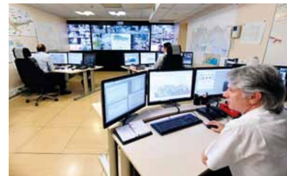
Les opérateurs de la salle d'exploitation du CIGM veillent 24h/24 à la sécurité des tunnels de la Principauté.
